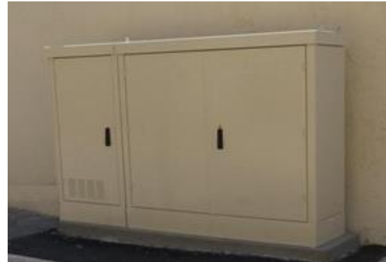
Armoire passive avec élément d'extension actif
